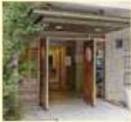
マンションエントランス
