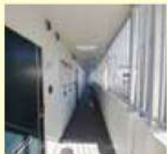
1Fの廊下は外部からの 侵入を防ぐ柵付き
